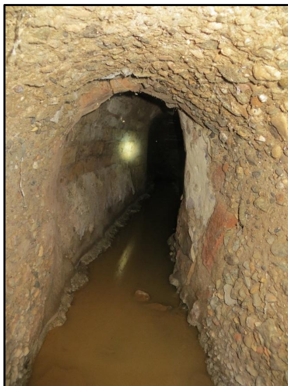
Fig. 16: Imatge del punt inicial del ramal del col·lector, a Mare de Déu del Port.
