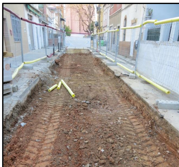
Fig. 52: Imatge on es pot apreciar el procés de rebaix de terres, amb l'estrat 905 present per tot el carrer.
