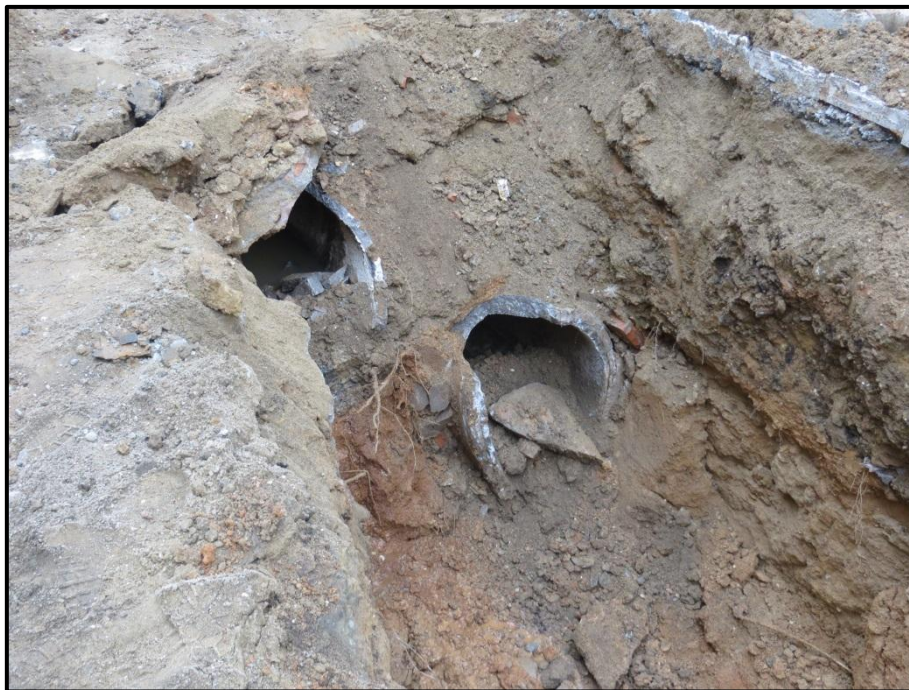
Fig. 35: Imatge on es poden apreciar les dues canonades ja a la part central del carrer.
