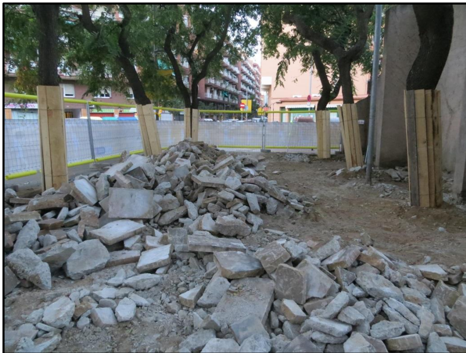
Fig. 40: Imatge del procés de demolició del paviment de la placeta.
