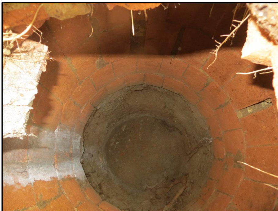
Fig. 44: Imatge de l'interior del pou cec.
