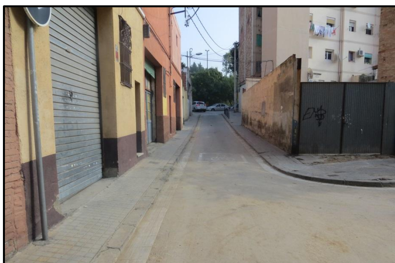
Fig. 27: El tram 3 del carrer de l'Aviador Duran.
