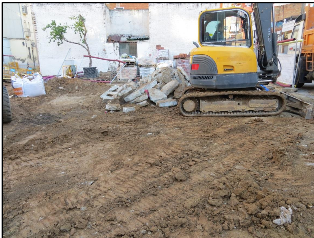
Fig. 47: Imatge del procés de demolició i rebaix de terres de la placeta.
