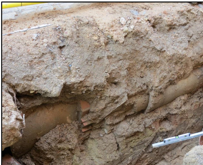
Fig. 33: Detall on es pot apreciar la superposició de les dues canonades.
