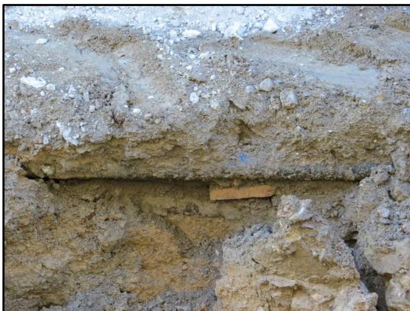
Fig. 22: Detall del tub per a servei elèctric en el perfil esquerra de la rasa del col·lector.
