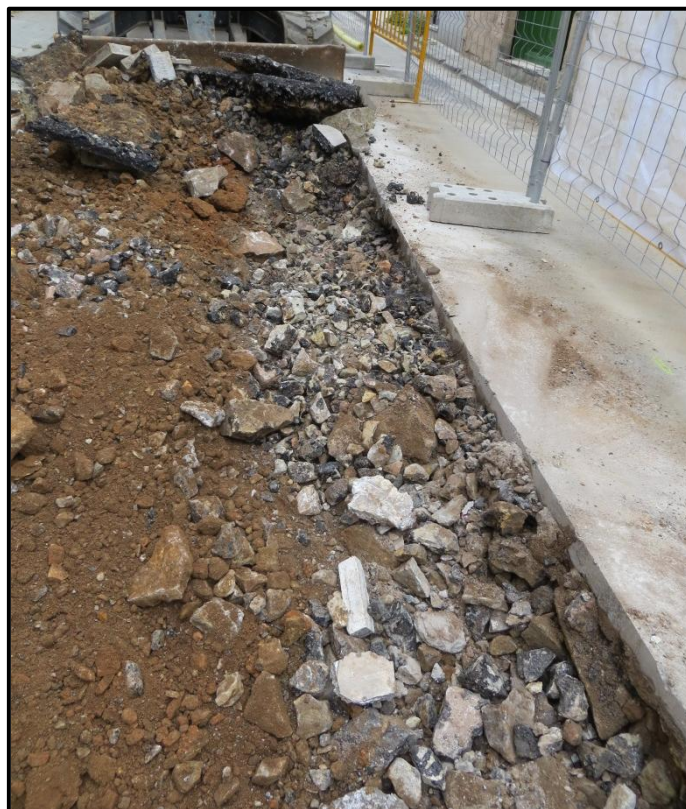
Fig. 49: Imatge on es pot apreciar el rebliment del retall 810, compostat per pedres i quitrà piconat.
