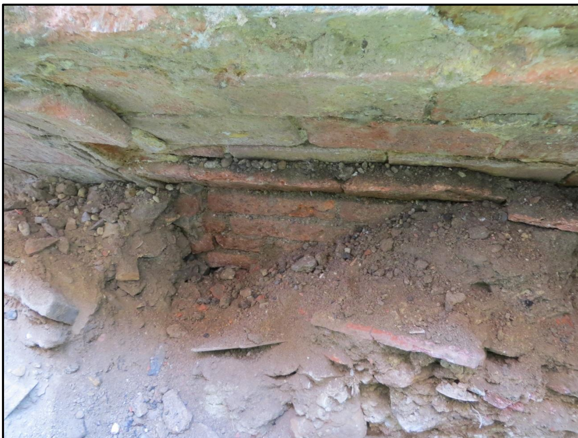
Fig. 56: Detall de la volta de totxana i la paret lateral de tancament de la segona cambra.
