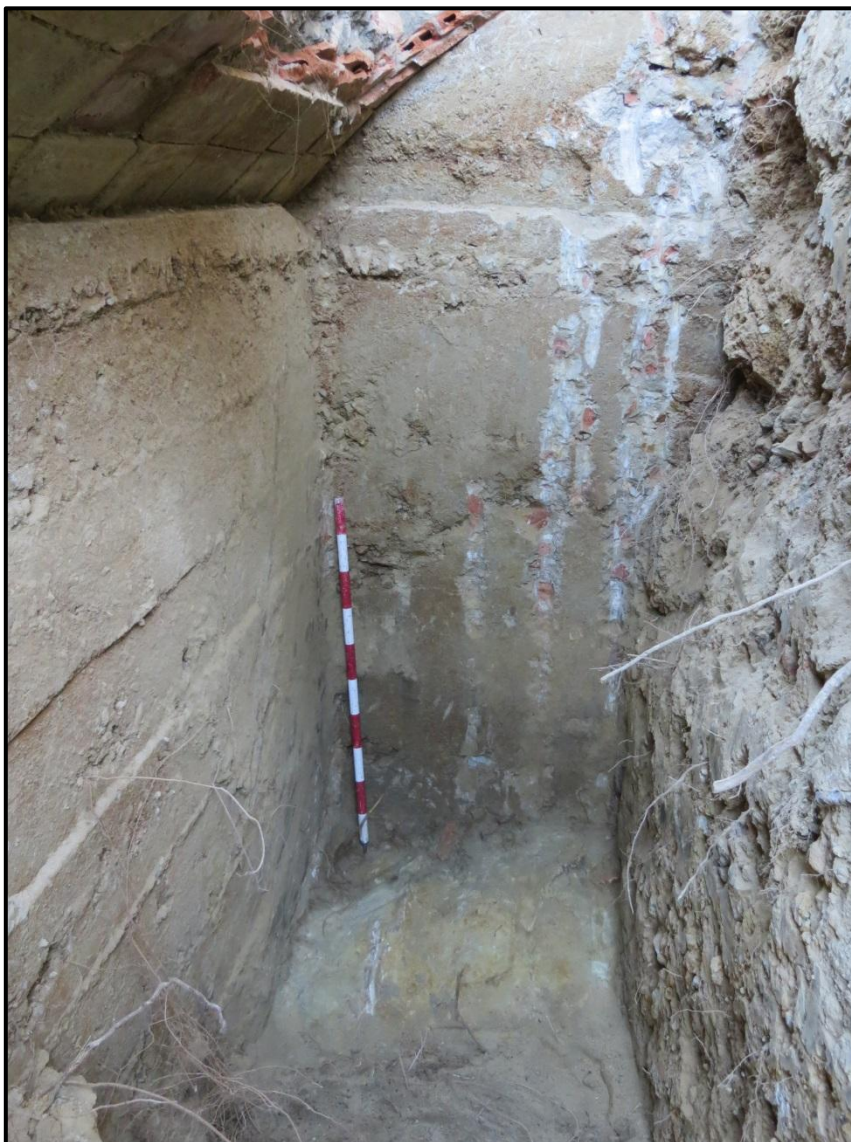
Fig. 55: Imatge de l'interior de la primera cambra.
