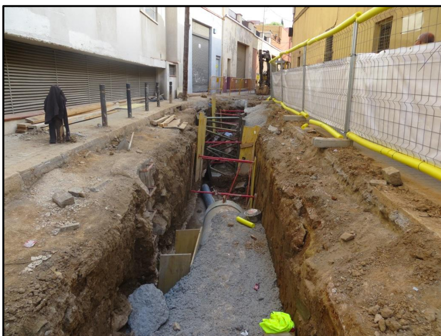
Fig. 24: Imatge de la rasa de col·lector en ple procés de realització.
